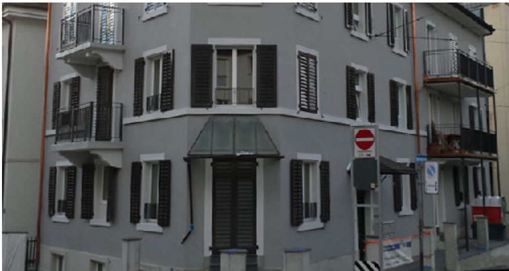
Vogelsangstr. 33, 8006 Zürich (nach Renovation 2014)
